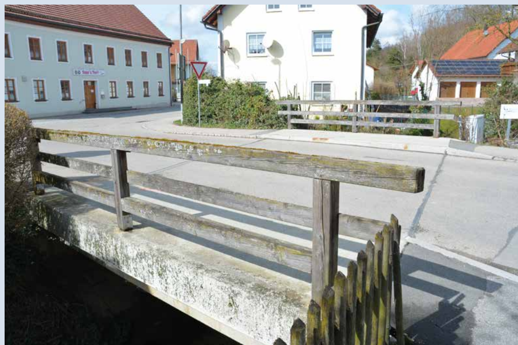
Der Landkreis Freising erneuert im Sommer die Brücke über den Haslreuther Graben in Hörgerthausen.
